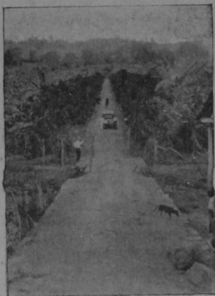
CAMINO DE MACADAM QUE ATRAVIESA LAS PROPIEDADES DE LOS SRES. LINDO
