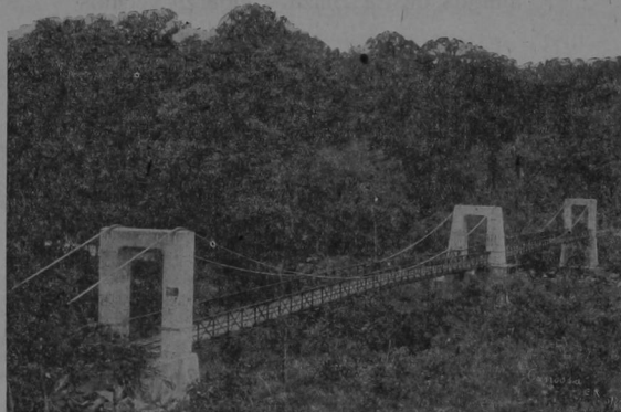
El gran puente de Chitaria construido por la Municipalidad de Turrialba
